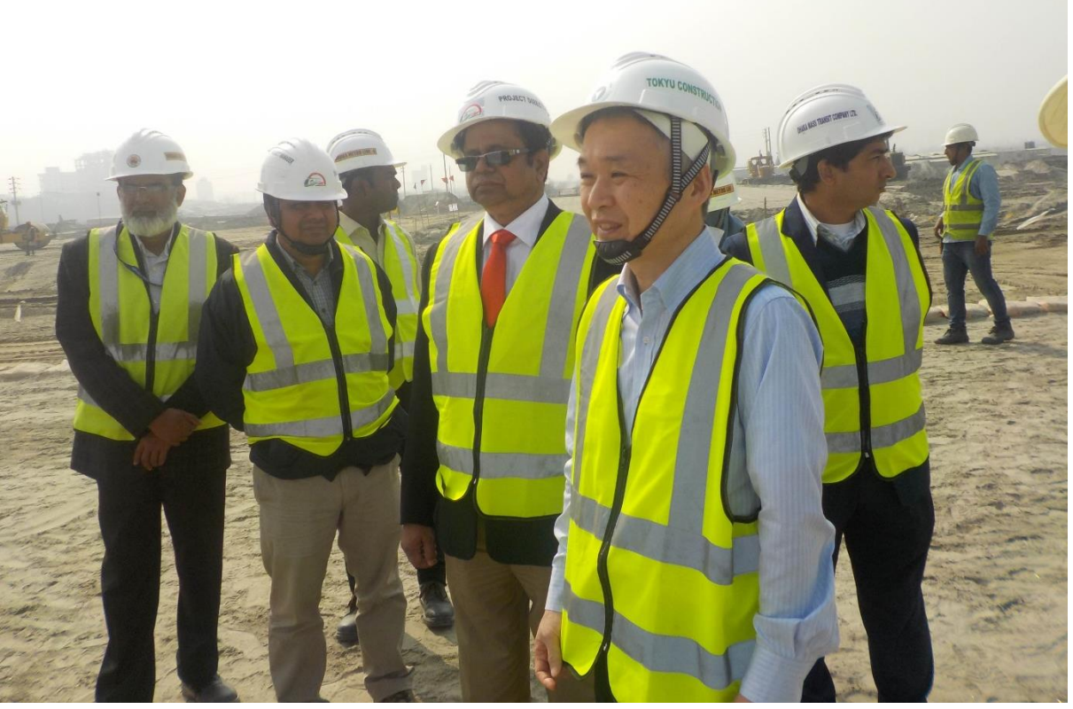
প্রকল্প পরিচালক MRT Line-6 সরেজমিনে উন্নয়ন কাজ পরিদর্শন করছেন
