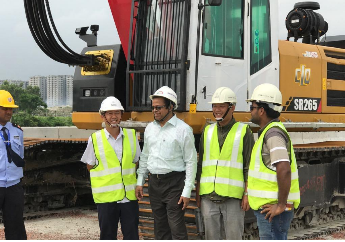
উত্তরা ডিপো এলাকায় Rotary Core Drilling (RCD) Machine দ্বারা চলমান piling কাজ
