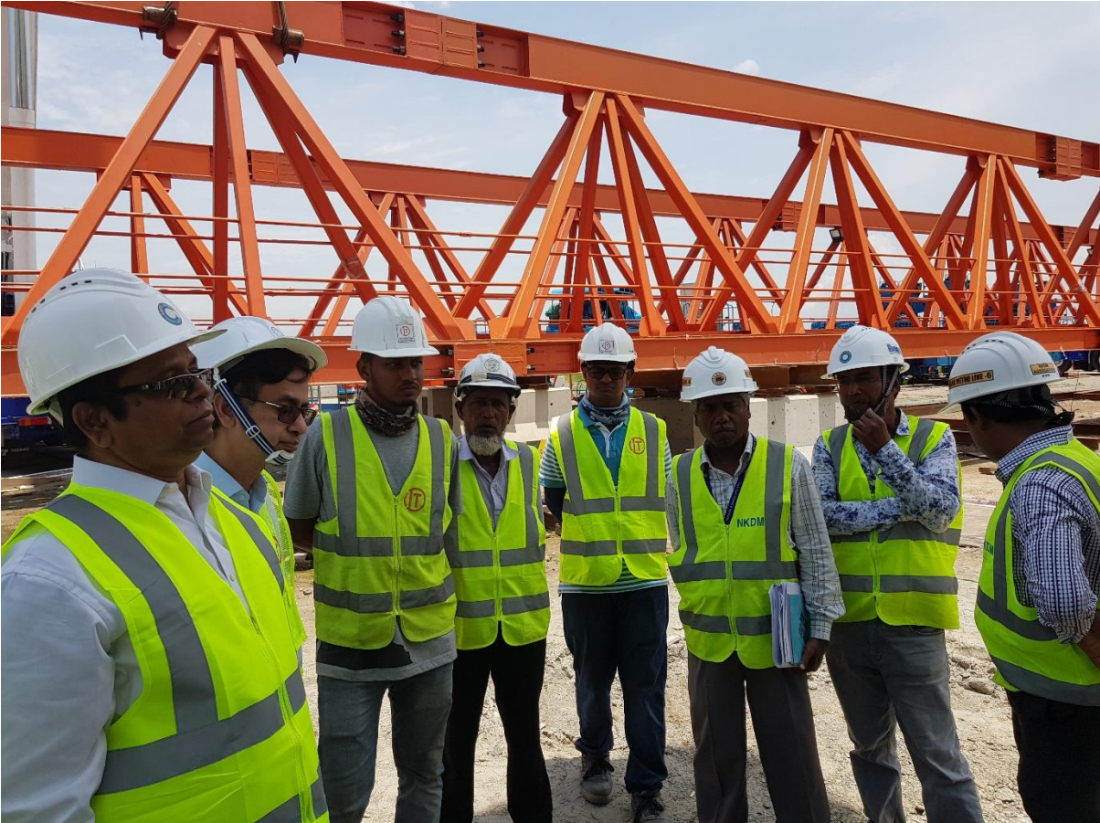
মেট্রোরেলের পিয়ার ৮৫ ও পিয়ার ৮৬ মধ্যবর্তী স্থানে ভায়াডাক্ট Erection-এর জন্য স্থাপিত Launching Grider
